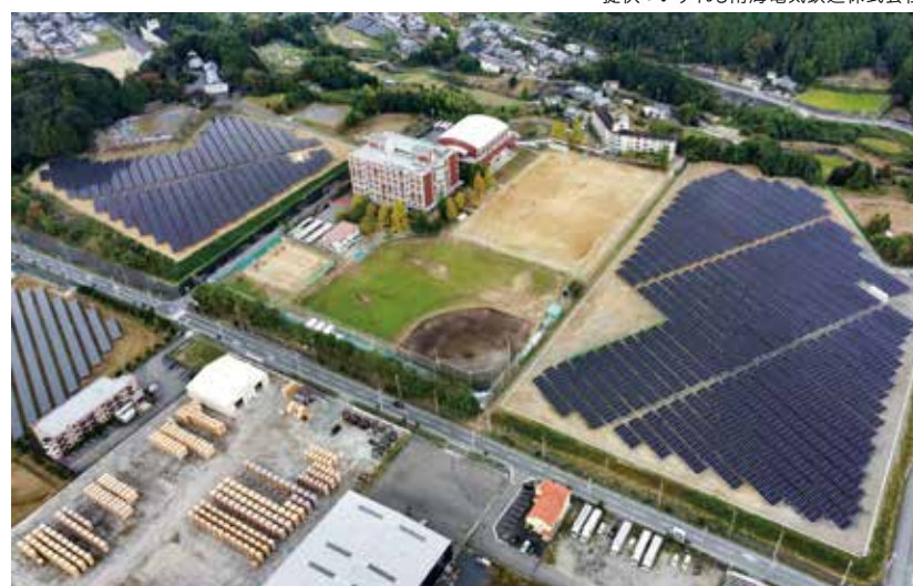
▲南海小峰台太陽光発電所
