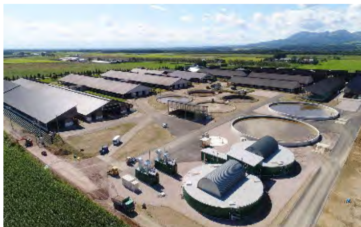
バイオガスプラント
