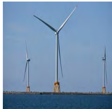
石狩湾新港洋上風力発電所
