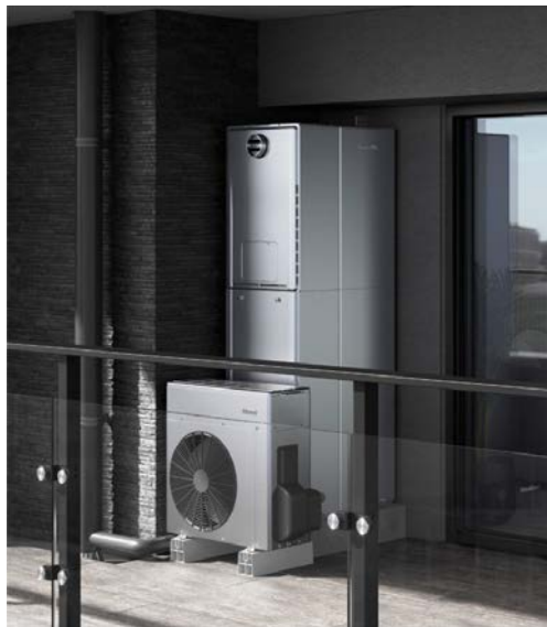
バルコニーに設置
